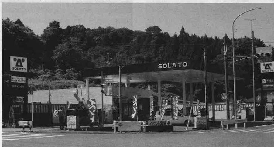
新城インターSS（運営：サンクスモビリティ）は国道151号線沿いに立地
